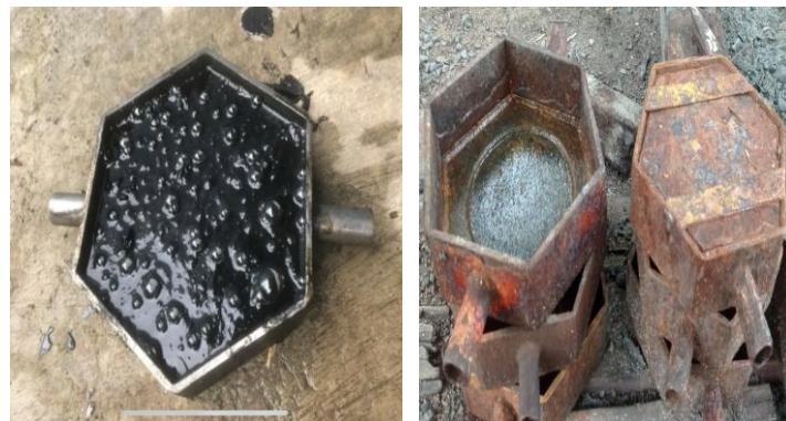
Gambar 4: Tahap pencetakan paving block
